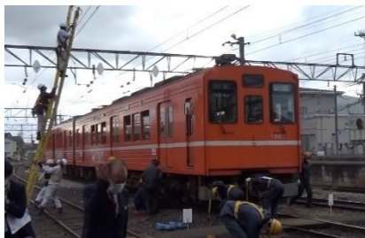
(線路・電車線復旧)
