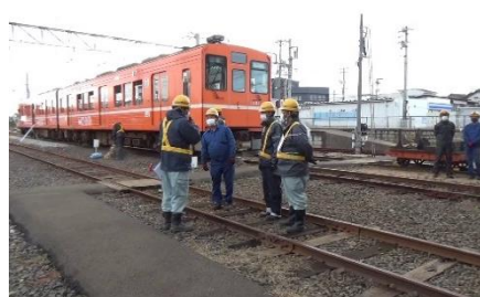
(復旧作業報告)
