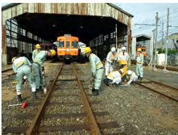
(線路・遮断機復旧)
