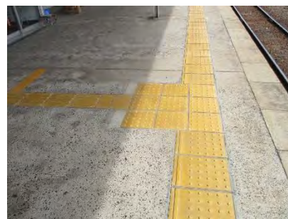
(内方線付点状ブロックの設置)
