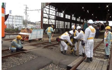
(線路・遮断機復旧)
