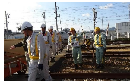
(線路・電車線復旧)
