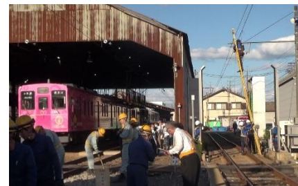
(線路・架線断線復旧)
